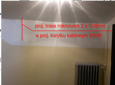
proj. trasa mikrourek 2 x 10/8mm w proj. korytku kablowym 60x40
